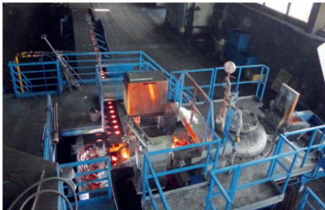
RGD 4/200 an einer Disamatik®-Formanlage
