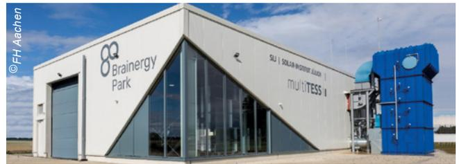
Wärmespeicher vor dem TESS 2.0 Gebäude, in dem die OTTOJUNKER Power-to-Heat-Anlage integriert ist.
